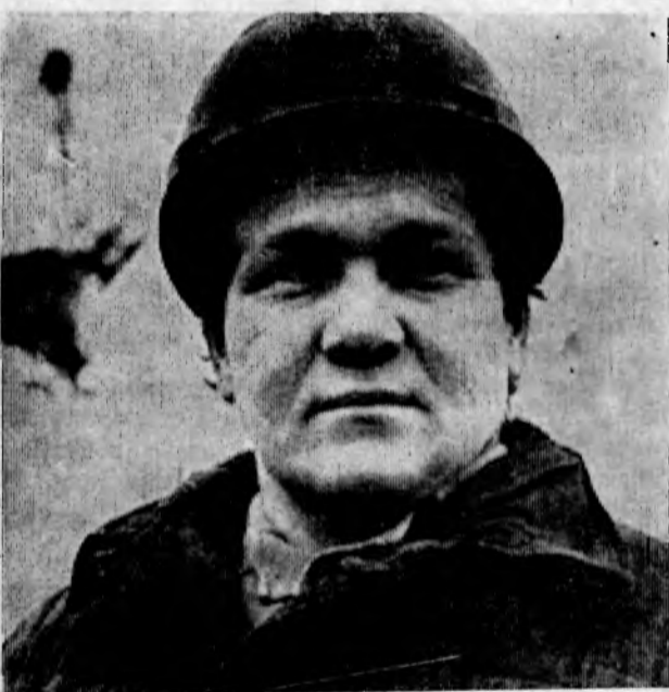
По-ударному работает на подготовке нарцисов под фундаментом сварщик бригады В. Утопова из СМУ-6 УС «Промстрой» Н. Кутепов. Фото В. КОМИССАРОВА.
